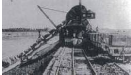
放水路を掘削する蒸気掘削機(大正時代)
