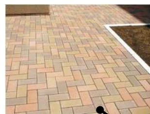
インターロッキングブロック舗装
