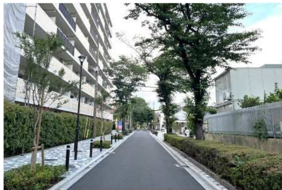
既存木を残しながら街路樹の更新を行った堀切四季のみち
