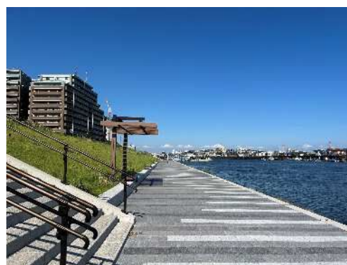
スーパー堤防事業とあわせて 整備された水辺空間 (江戸川区)
