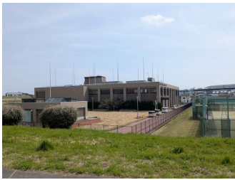
東金町ポンプ所
