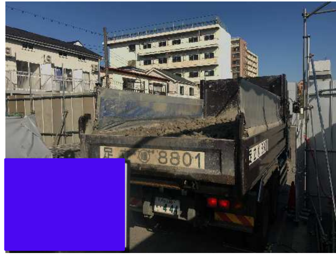
他現場の参考例（解体材及びコンクリートガラの積込・搬出）
