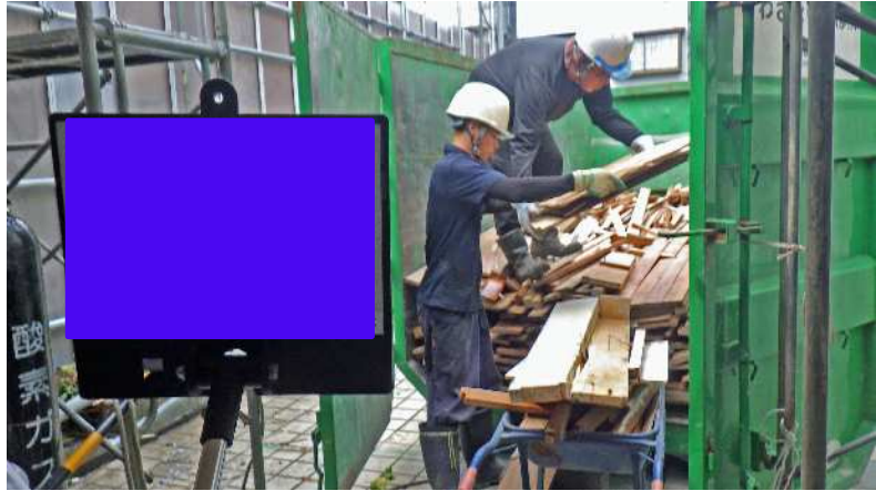
他現場の参考例（解体材及びコンクリートガラの積込・搬出）
