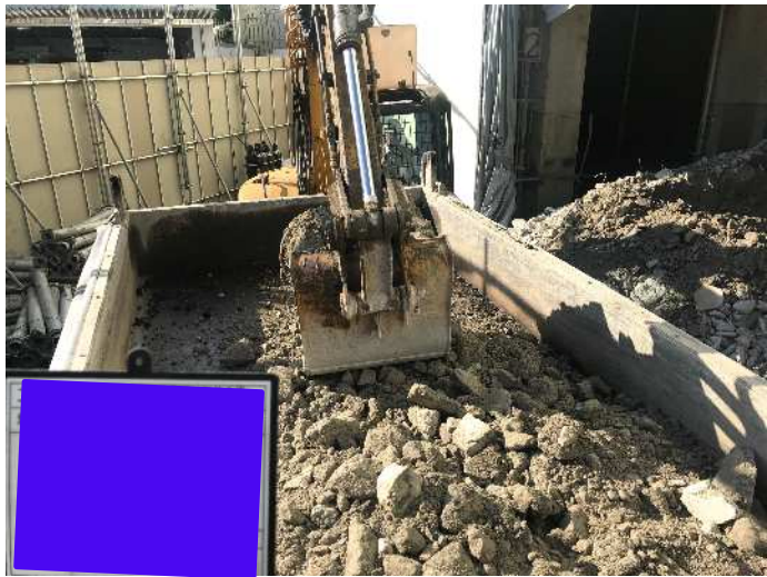
他現場の参考例（解体材及びコンクリートガラの積込・搬出）
