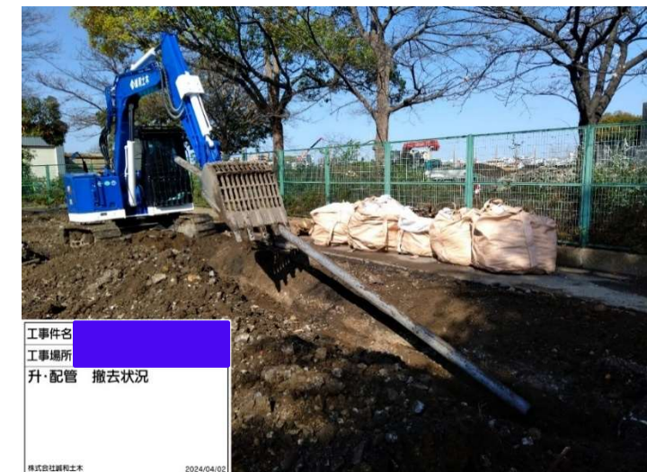
配管・桝類等撤去
