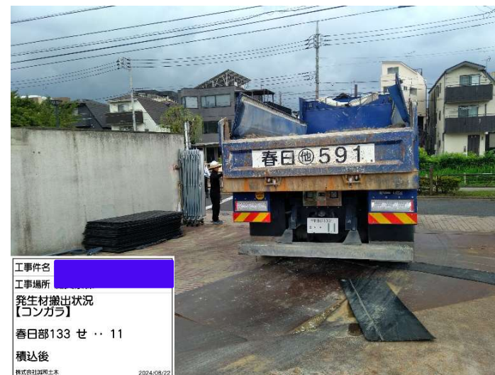
10トダンパカーにて発生材（コンガラ）の搬出
