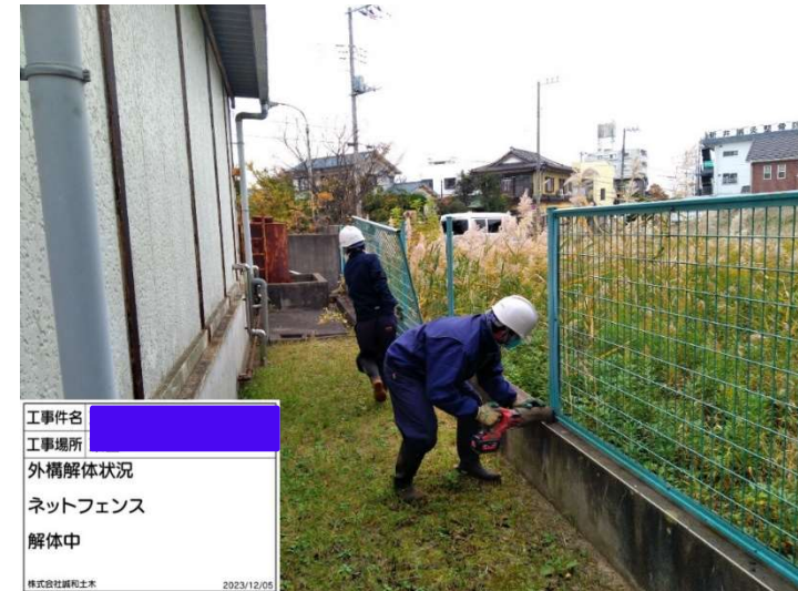
フェンス撤去
