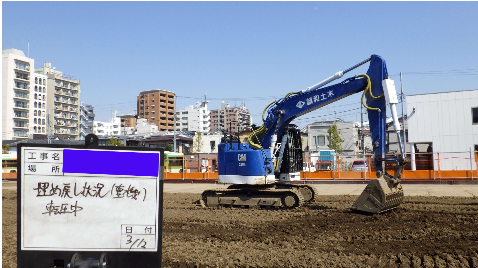
他現場の参考写真(埋戻し・整地状況)
