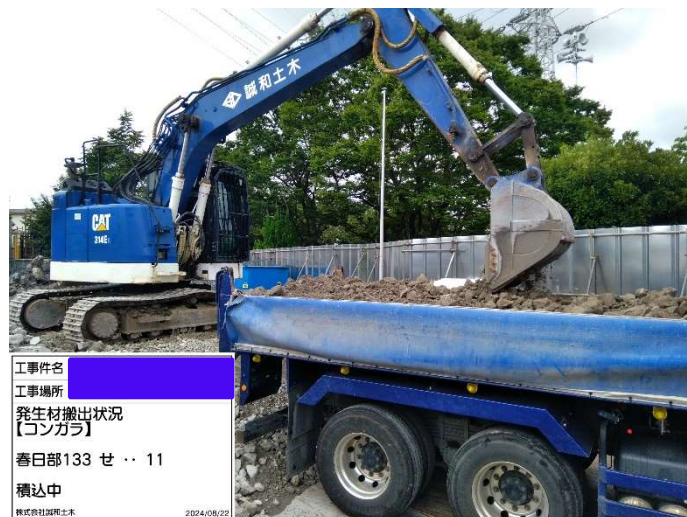
10トダンパカーにて発生材（コンガラ）の搬出
