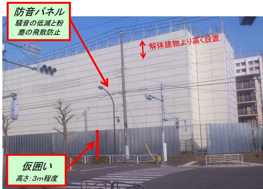
仮囲い/枠組足場+防音パネル
