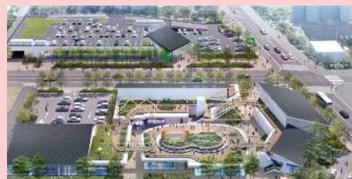
都営団地の 建替創出用地 活用整備 （東大和市東京 街道団地地区）
