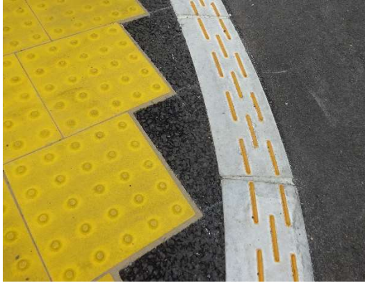
歩車道間の段差に配慮した 歩道巻き込み部
