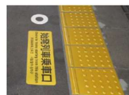
内方線付き点状ブロック
