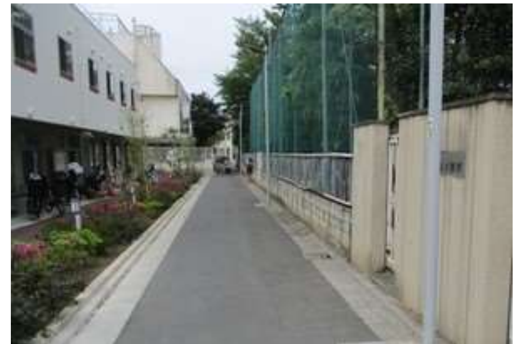
＜板橋区細街路拡幅整備後の道路＞
