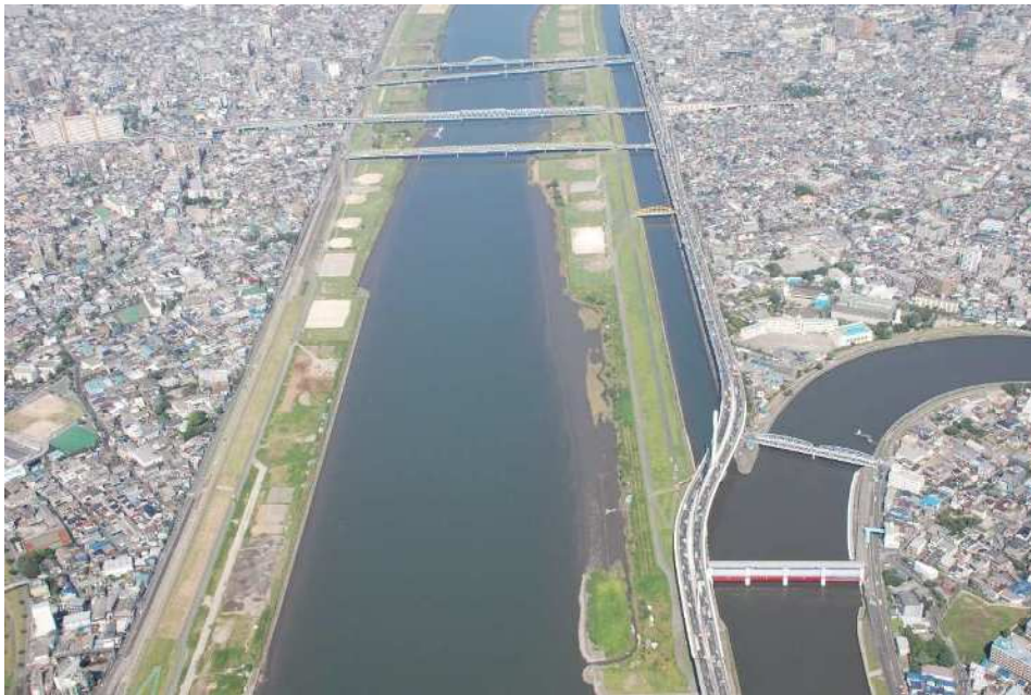
四ツ木駅ブロック付近の荒川（7.25km～9.0km）
