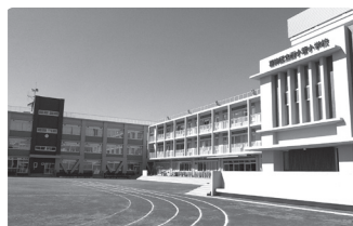
▲ 令和5年9月に工事が完了した西小菅小学校
