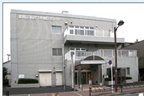
東四つ木地区センター外観
