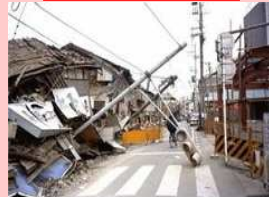
電柱崩壊による通行の妨げ
