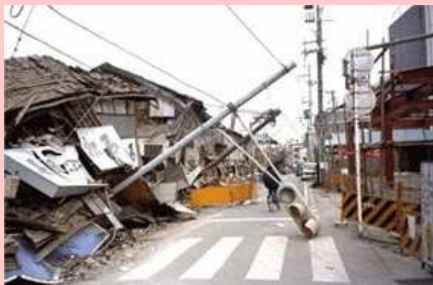
電柱崩壊による通行の妨げ (国土交通省HPより)
