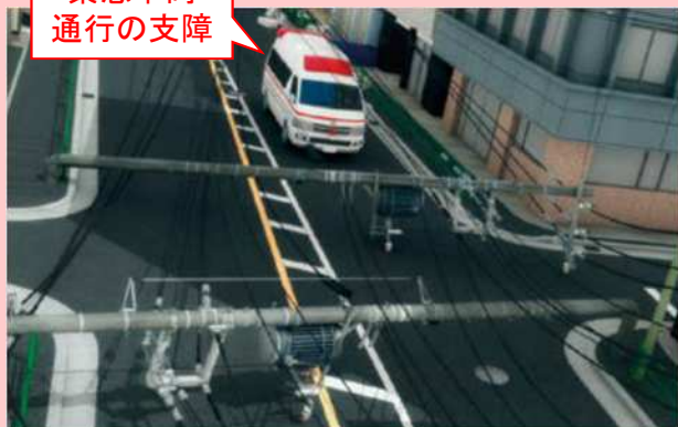
電線による救助活動の妨げ (東京都HPより)
