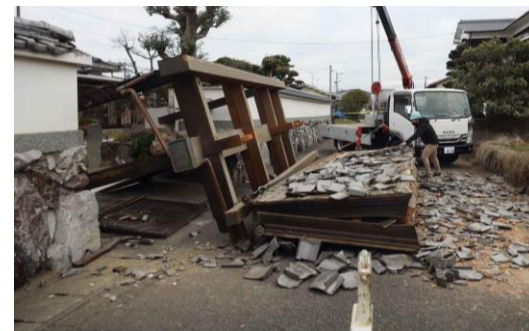
門や塀の倒壊による道路寸断 (熊本地震)
