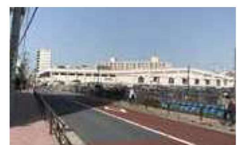
② 西側から見た自動車教習所建物
