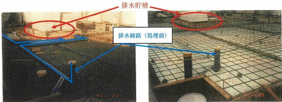
(写真C: 排水経路(処理前)の設置状況①)
