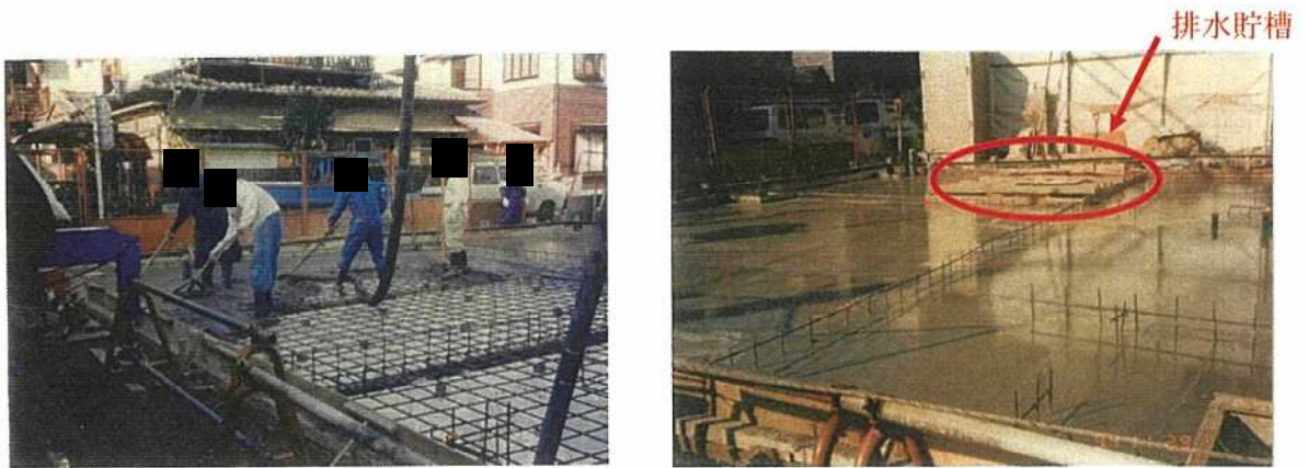
(写真E: コンクリート打設状況①)
