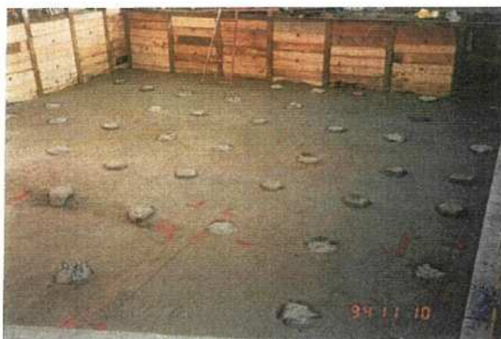
(写真A: 深度1.5m付近の基礎状況①)
