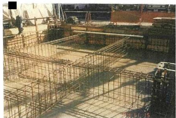
(写真B: 深度1.5m付近の基礎状況②)
