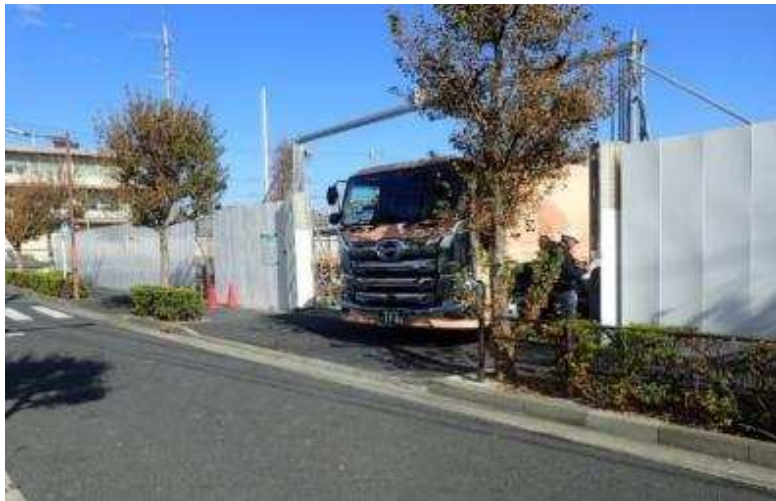
仮囲い及びゲート
