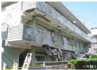
マンションの2階廊下部分が崩落した事例
