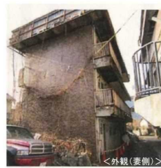
外壁、手すりが崩落した事例
