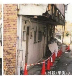
外壁、手すりが崩落した事例
