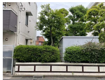
⑥南側道路から北方向を見る
