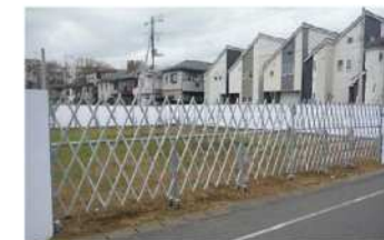
工事用ゲート
