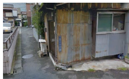
細街路拡幅整備（前）
