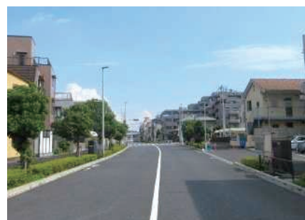
補助第276号線（隅田橋）
