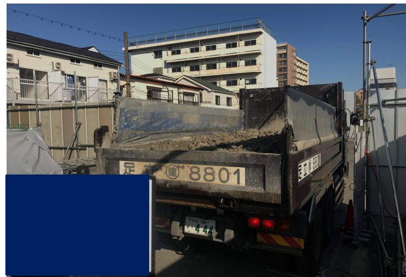
10トンダンプカーによる発生材の搬出
