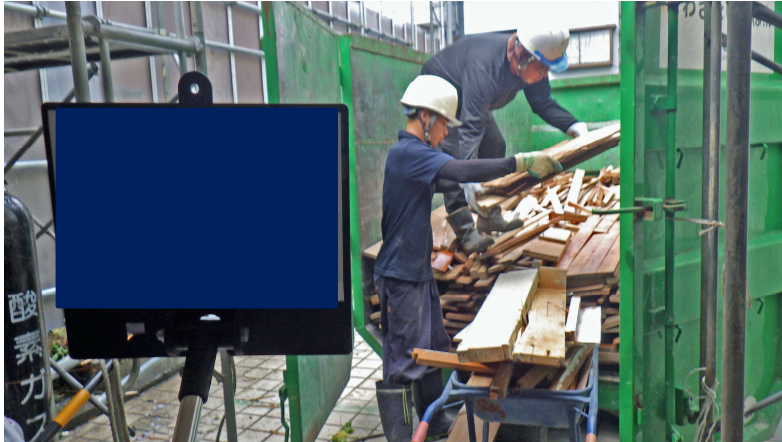
4トンテナ車による発生材の搬出
