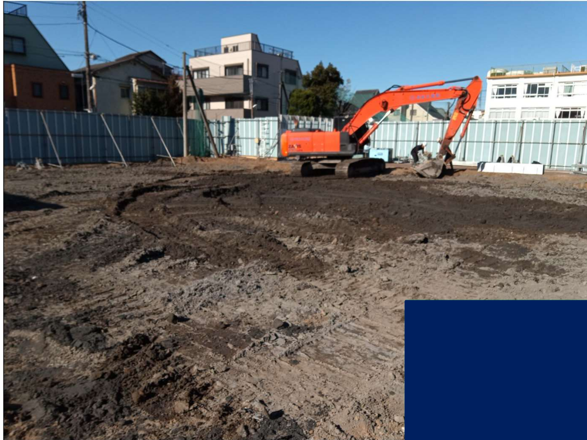
他現場の参考例（埋戻し・整地状況）
