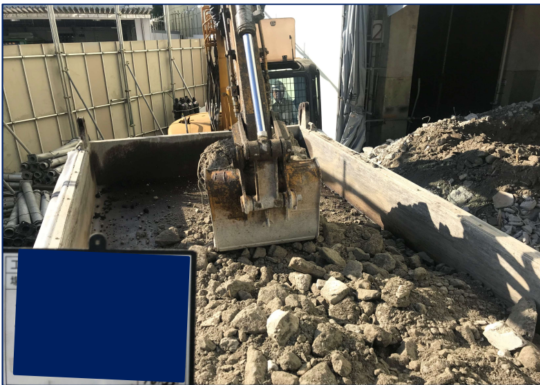
10トンダンプカーによる発生材の搬出
