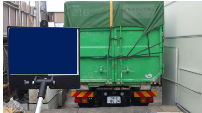
4トンテナ車による発生材の搬出
