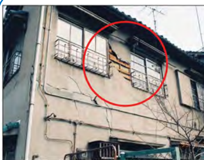
壁：損傷程度50%
