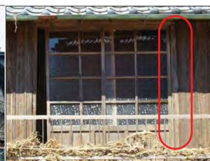
建具：損傷程度25%
