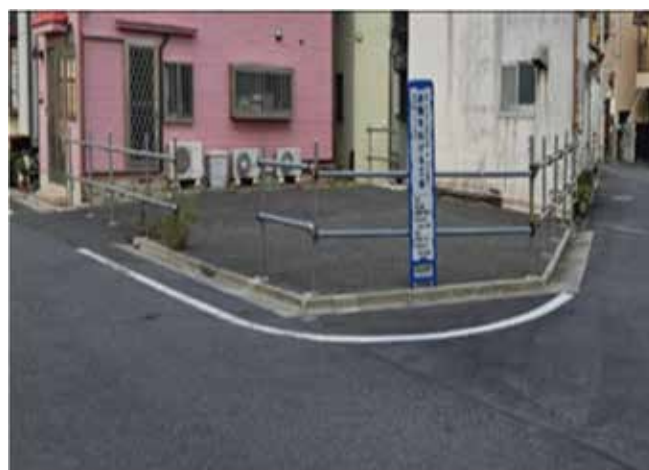
南北道路 A 南側ポケットパーク(工事前)
