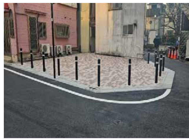
南北道路 A 南側ポケットパーク(工事後)
