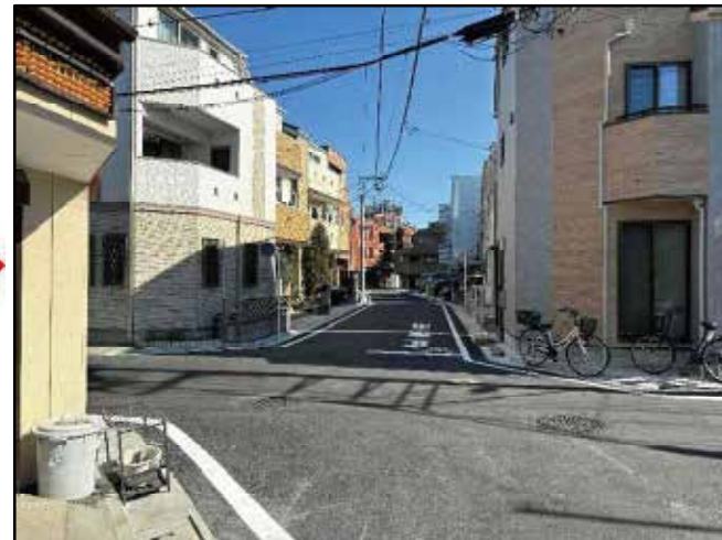
北西道路南区間(工事後)
