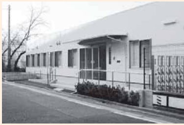
建設中のこすげ地区図書館(1/4 現在)
