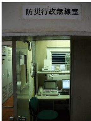
狭い防災無線室
