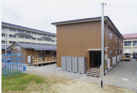
仮設住宅 (石川県輪島市門前町)
