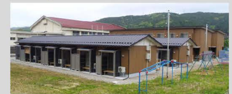
応急仮設住宅(輪島市門前町)
