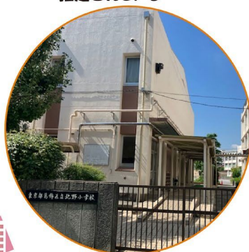
「北野小学校」 指定避難所、災害時給水ステーションに 指定されている
