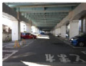
高架下の駐車場
