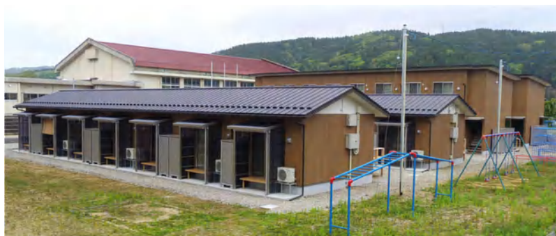
応急仮設住宅(輪島市門前町)
