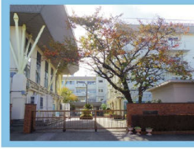
▼老朽化した建物
