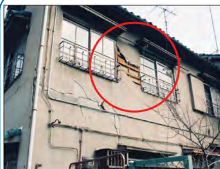
壁：損傷程度50%
