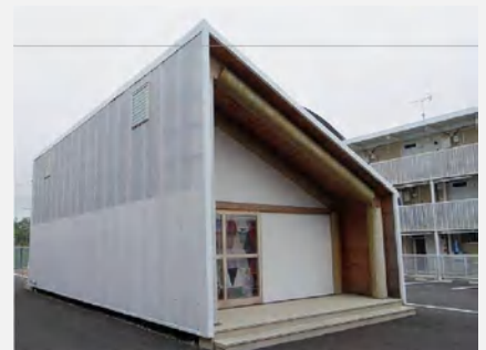
仮設集会所 (宮城県女川町)
