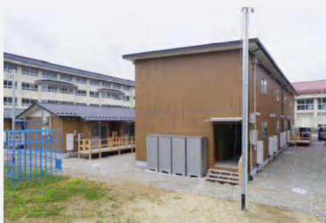
仮設住宅 (石川県輪島市門前町)
