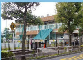
洪水時緊急避難建物 (児童館)
