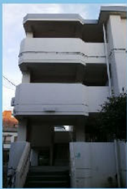
洪水時 緊急避難 建物 (区営住宅)
