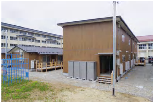
応急仮設住宅(石川県輪島市門前町)
