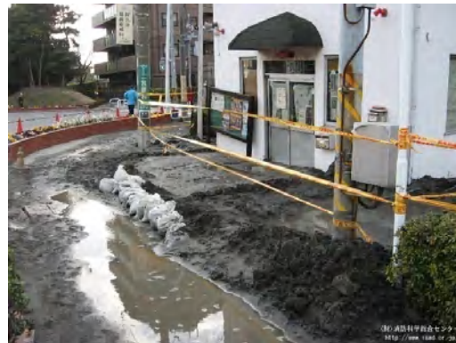
液状化被害(イメージ) 液状化の様子(千葉県浦安市) (一般財団法人消防防災科学センター 「災害写真データベース」)
