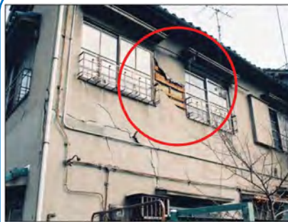
壁：損傷程度50%
