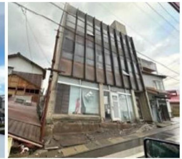
傾斜が残るRC造
