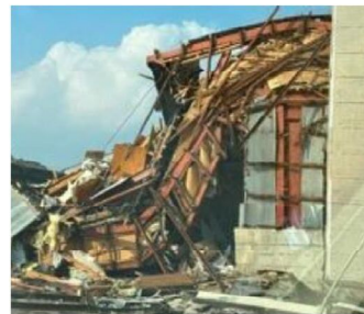
崩壊・傾斜した鉄骨造
