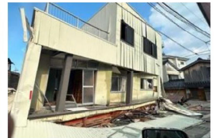
崩壊・傾斜した鉄骨造
