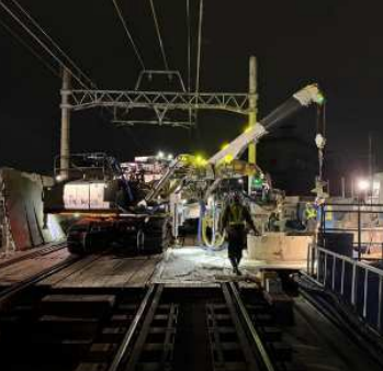
土留杭設置の様子（夜間作業）
