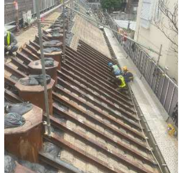
作業構台設置の様子
