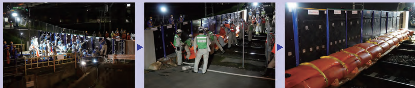
止水板の組み立て
