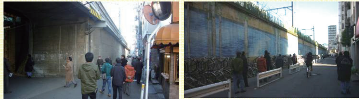
三ノ輪橋駅の高架脇の空間
