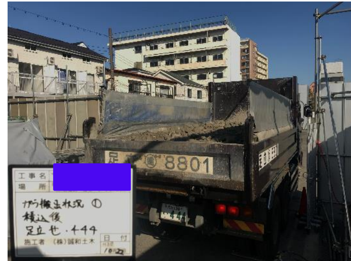
他現場の参考例(解体材及びコンクリートガラの積み込・搬出)
