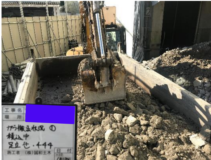
他現場の参考例(解体材及びコンクリートガラの積み込・搬出)
