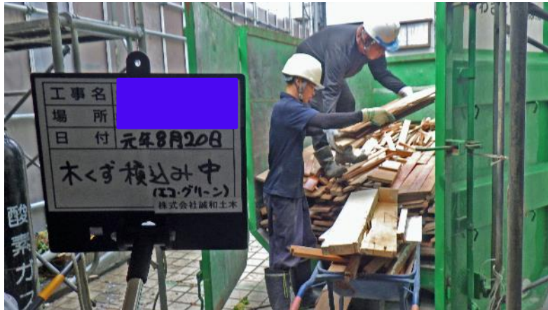
他現場の参考例(解体材及びコンクリートガラの積み込・搬出)
