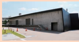
災害備蓄倉庫
